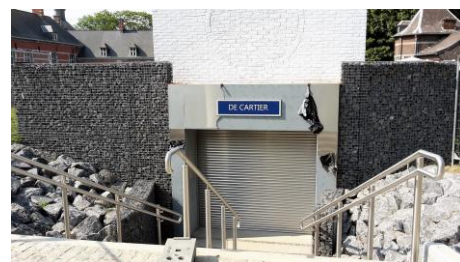
Nouvel accès vers l'administration communale
