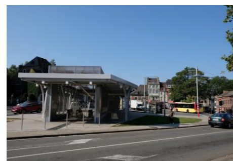
Nouvel accès et escalator - Place Albert 1er
