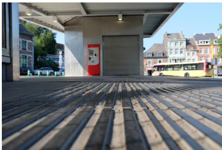
Tracé podotactile PMR
